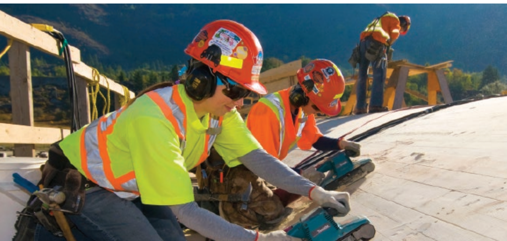
Charpentiers exécutant des travaux dans le cadre du projet d'expansion hydroélectrique de Waneta sur la rivière Pend d'Oreille. Photo reproduite avec l'aimable autorisation de Columbia Power Corporation..
