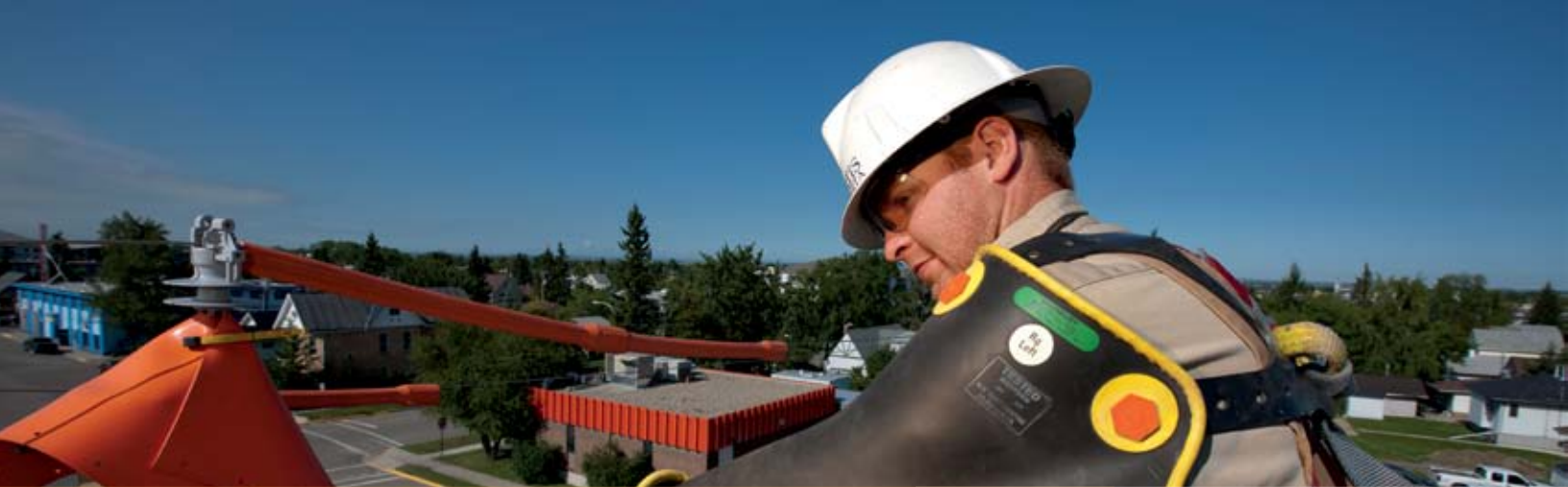
Le monteur de lignes Travis Phillips, de FortisAlberta, effectue des travaux sous tension.
