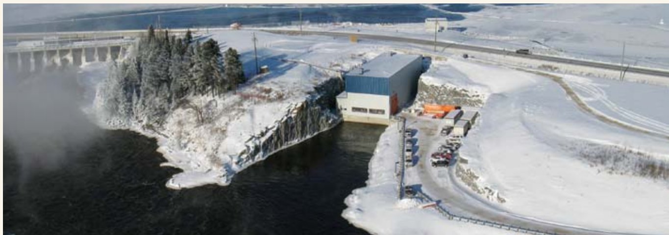
La centrale du lac Seul (White Pine Narrows pour les Ojibways), dans le nord-ouest de l'Ontario, est la plus récente centrale hydroélectrique d'OPG.
