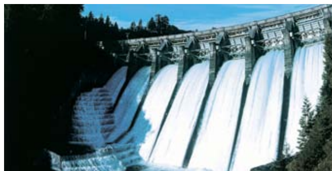
Barrage Ruskin de BC Hydro.
