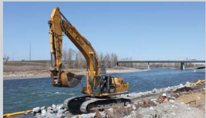
ENMAX Power a complété un projet de stabilisation des rives le long de la rivière Bow, à Calgary, en 2010, aménageant une structure permanente constituée de roches et de végétation afin de protéger les installations de transport et de distribution contre toute érosion future. Elle a du même coup créé un habitat naturel attrayant pour la faune.
