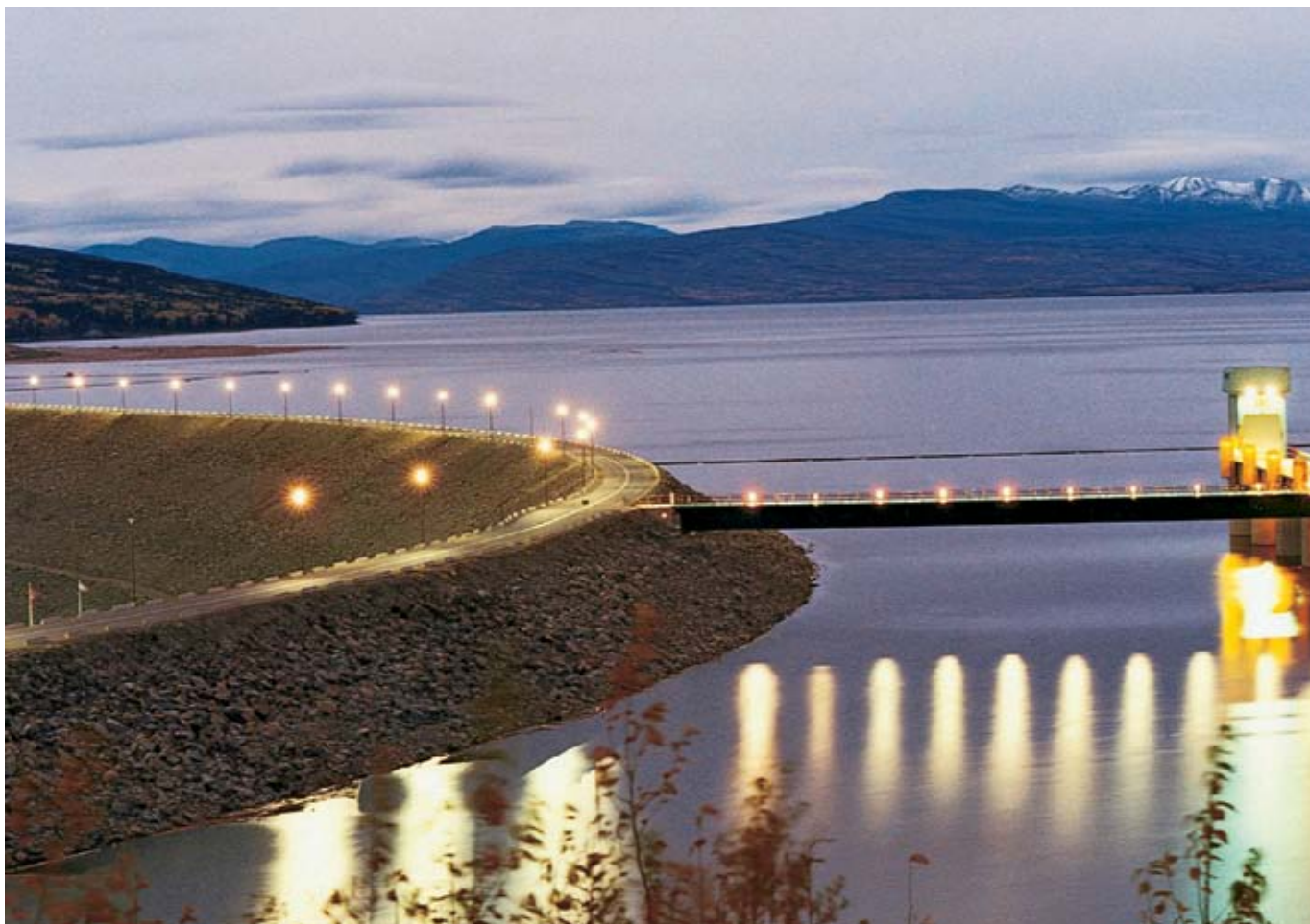
Le barrage W.A.C. Bennett de BC Hydro.
