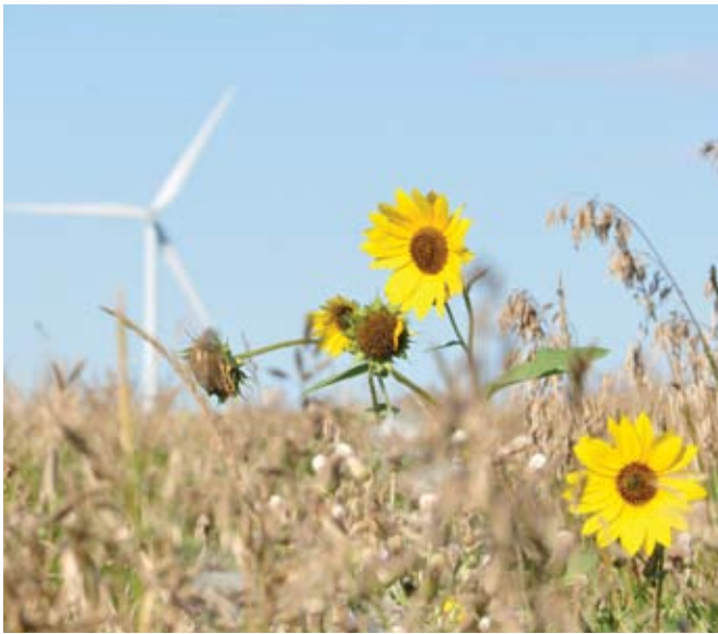
Éolienne de TransAlta, près de Pincher Creek, en Alberta.
