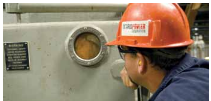
Un employé d'OPG surveille les essais de brûlage de biomasse à la centrale d'Atikokan.
