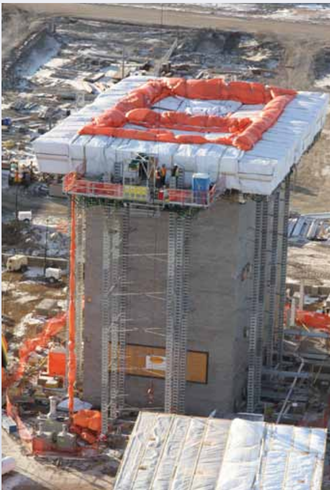
Mise en place d'un absorbeur de CO 2 et de SO 2 dans le cadre du projet de démonstration de captage et de stockage intégrés du carbone de Boundary Dam.
