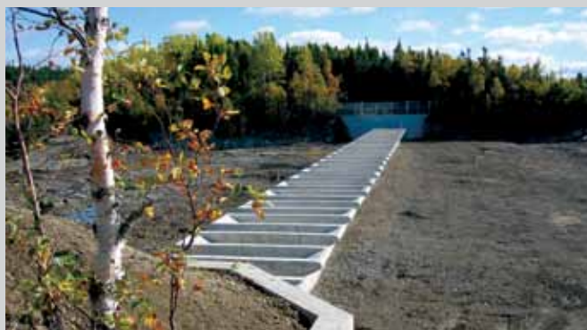
Nouvel évacuateur de crues de type « touches de piano » de Rattling Brook.
