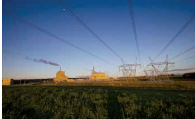
Centrale au charbon de Keephills, en Alberta.
