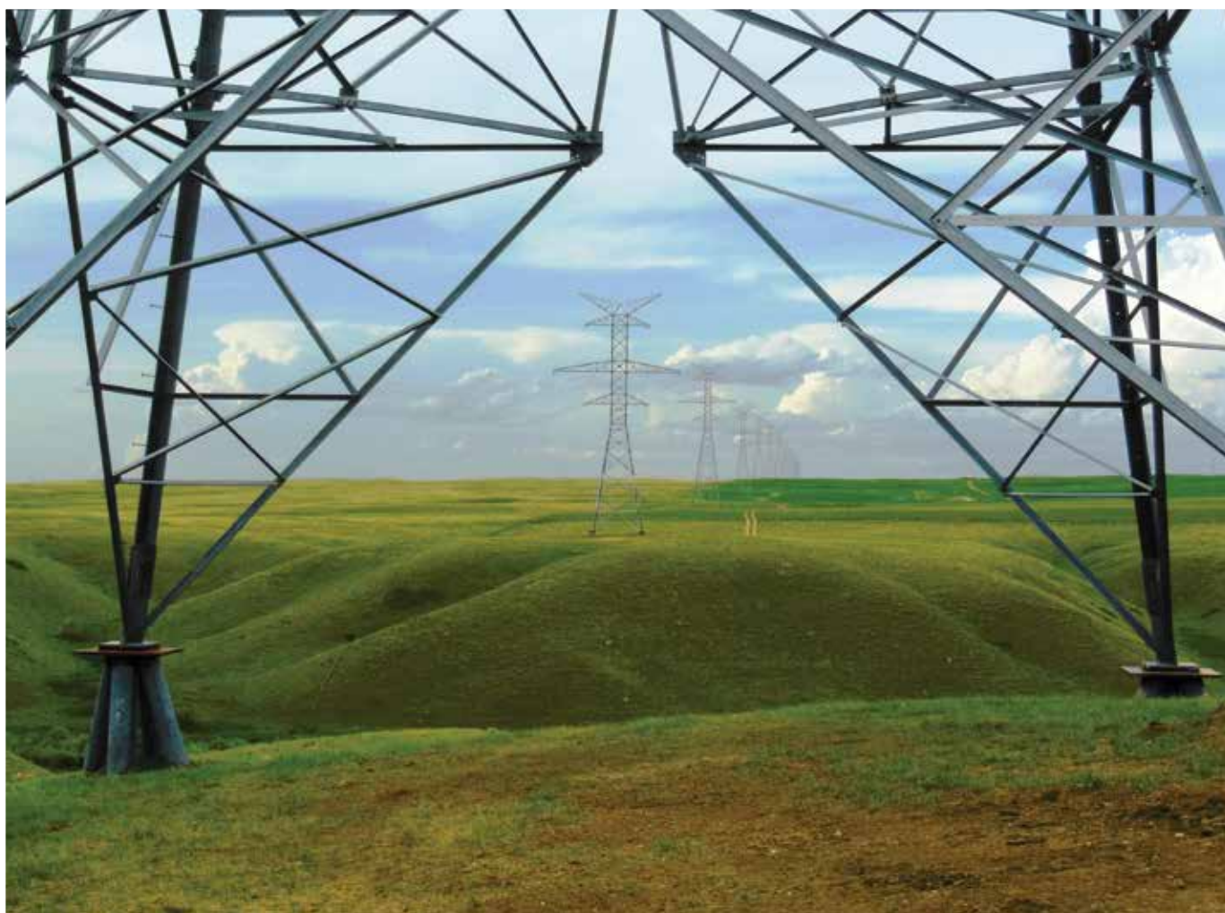
Le projet de transport d'AltaLink entre Bowmanton et Whittla, une ligne de transport de 240 kV s'étendant de l'est de Medicine Hat jusqu'au sud de Whittla, a été construit sur des pieux vissés. Photo reproduite avec l'aimable autorisation d'AltaLink.
