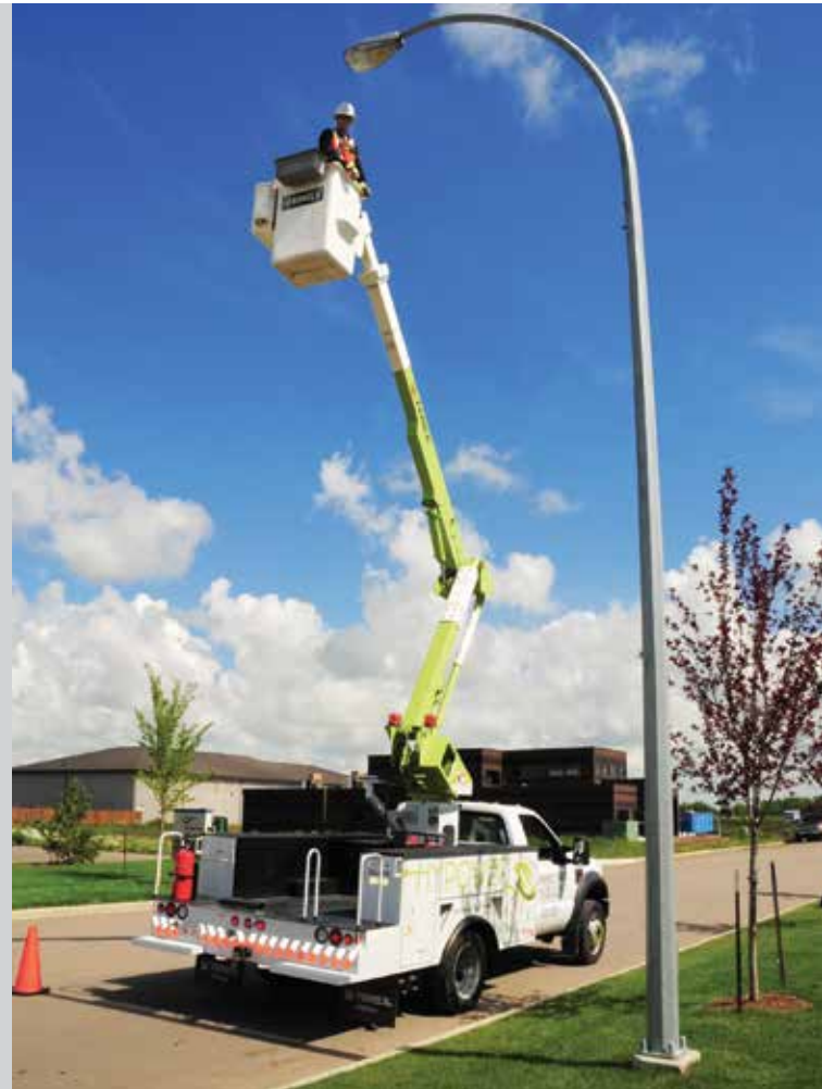
Un travailleur effectue des réparations dans un quartier résidentiel. Photo reproduite avec l'aimable autorisation de FortisAlberta inc.
