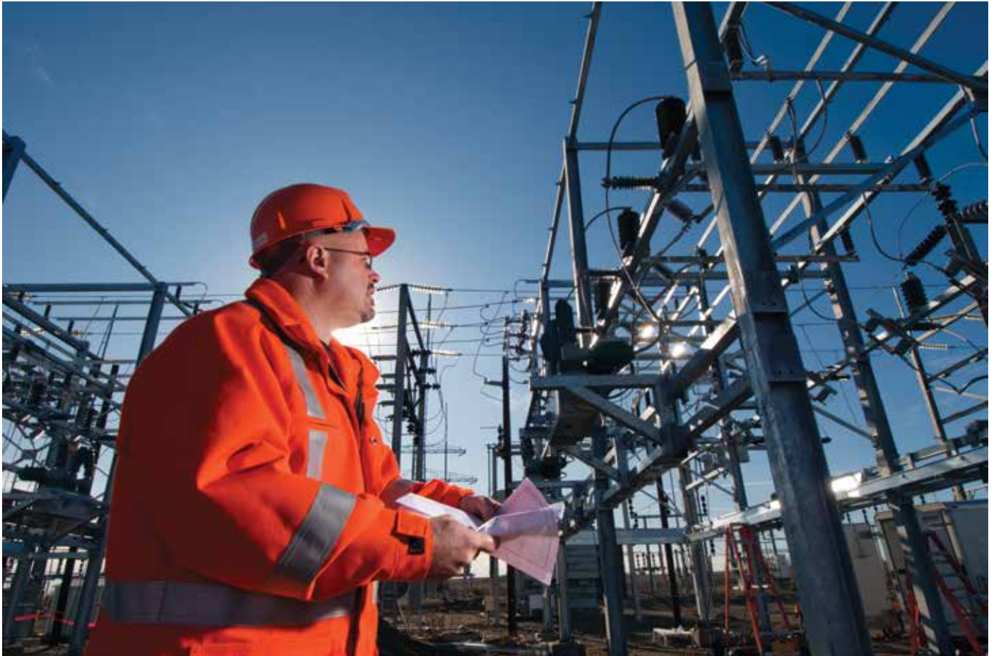
Un monteur de lignes de SaskPower étudie des plans dans un poste. Photo reproduite avec l'aimable autorisation de SaskPower.
