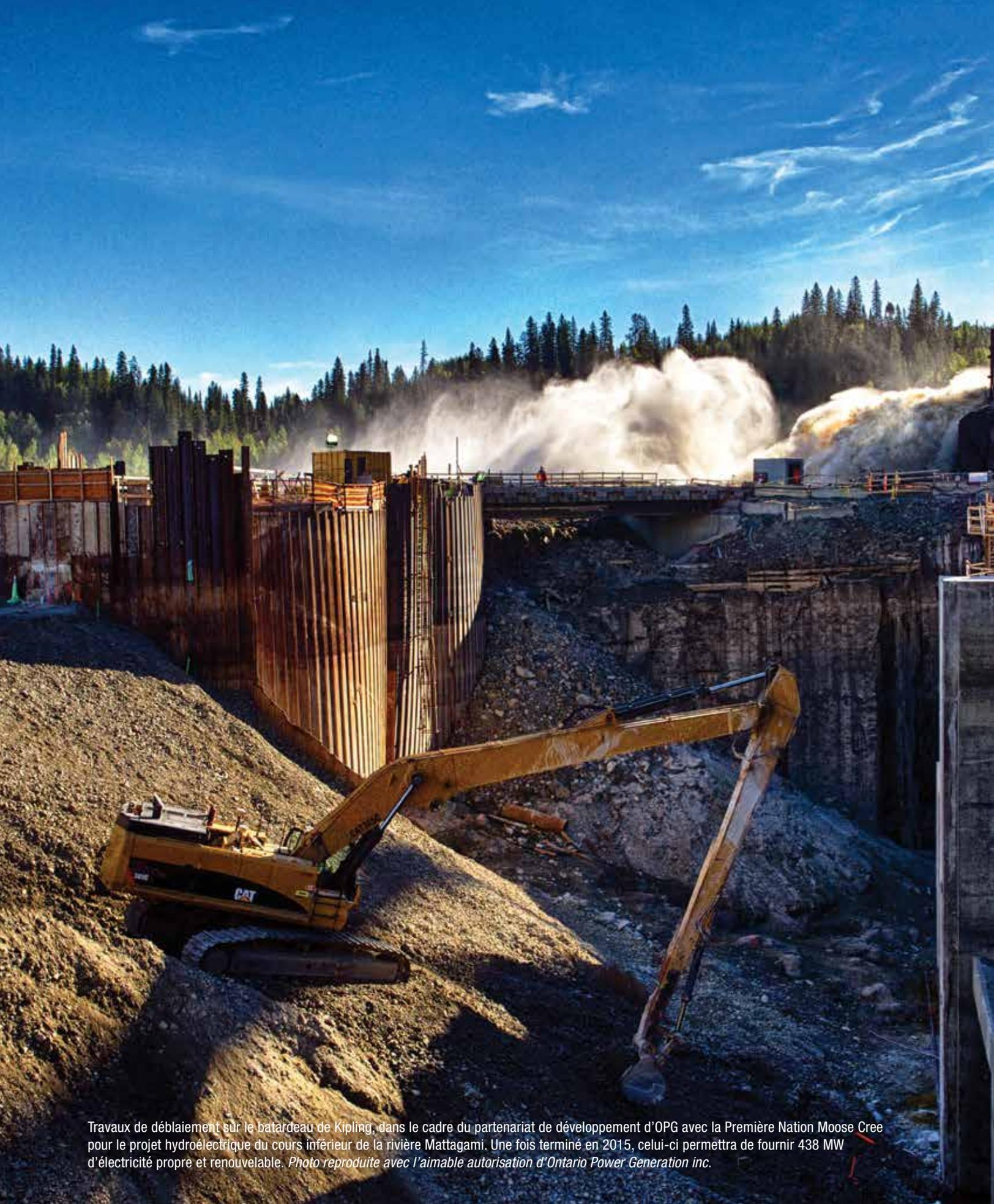
Travaux de déblaiement sur le batardeau de Kipling, dans le cadre du partenariat de développement d'OPG avec la Première Nation Moose Cree pour le projet hydroélectrique du cours inférieur de la rivière Mattagami. Une fois terminé en 2015, celui-ci permettra de fournir 438 MW d'électricité propre et renouvelable. *Photo reproduite avec l'aimable autorisation d'Ontario Power Generation inc.*
