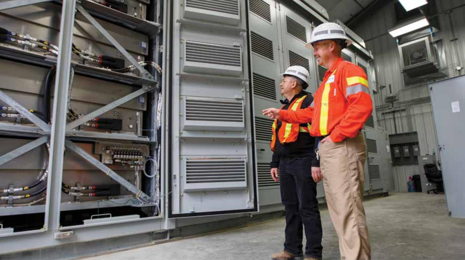
Trevor Wareham, sous-contremaître électricien chez BC Hydro, et Vlad Kositsky, chef de projet chez BC Hydro, pendant l'inspection de l'un des quatre modules de batteries sodium-soufre. Une fois reliés, ces quatre modules de batteries génèrent la puissance d'un mégawatt. *Photo reproduite avec l'aimable autorisation de BC Hydro et Power Authority.*
