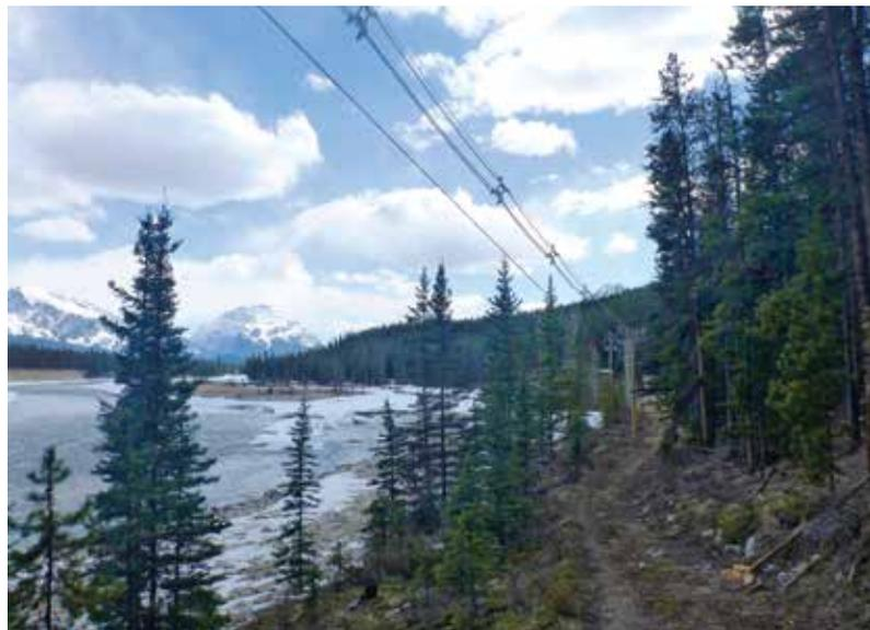
Une section du dispositif de câbles d'espacement aériens, venant d'être installé le long de la rivière Astoria. *Photo reproduite avec l'aimable autorisation d'ATCO Electric.*
